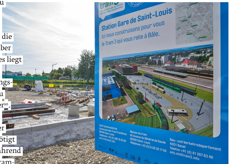
Abb. 4: Ausbau der Tramlinie 3, 2017
